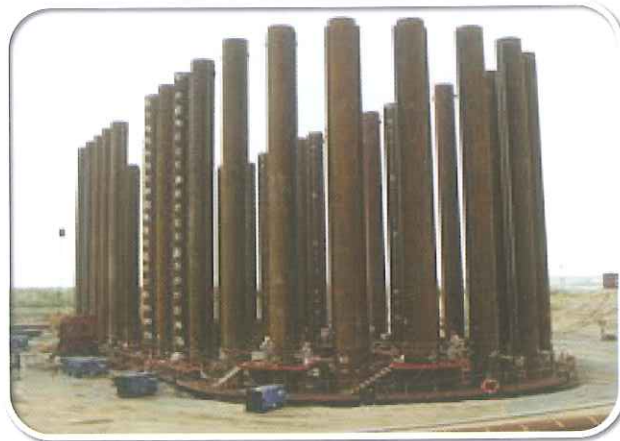
Xây dựng (Construction)
